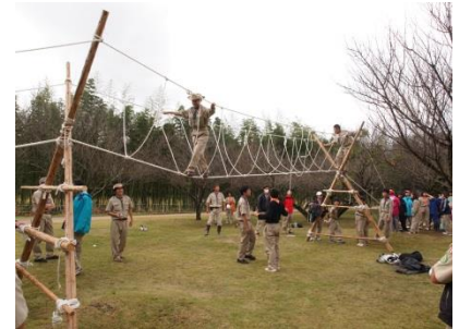
完成したモンキーブリッジを渡るスカウト
